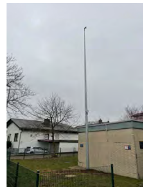
Eigene Grundstücke (neuer Mast)
